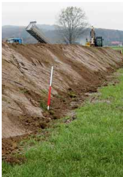
Schüttung eines Zwischenlagers mit Material vom Elliker Feld. Nächstes Frühjahr soll dieses Material fachgerecht aufgetragen werden.
